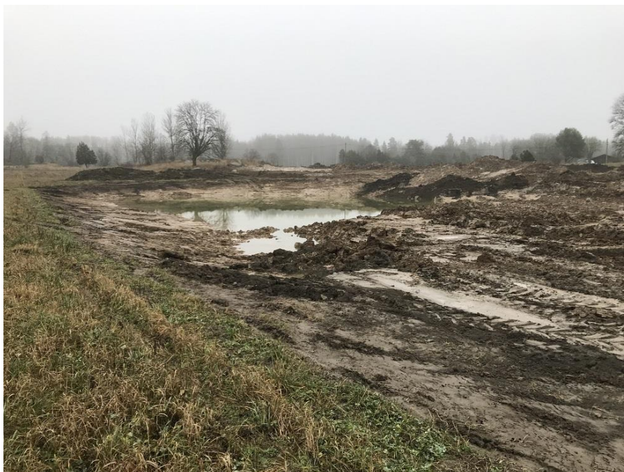
Bild 1: Djupdelen schaktad och matjord på grunddelen avbanad, 201217.
