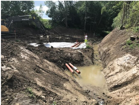
Bild 5 (vänster): Intagsrör lagda, intagshål uttaget och skyddande metallsil på det primära intagsroret installerad. Liten djuphåla för intagsroren utgrävd i diket. Bild 6 (höger): Stensättning lagd som erosionsskydd nedanför vägtrumman samt på den stabiliserande sektionen nedströms intaget. Vattennivån i djuphålan håller på att stiga. Fotot taget den 14 juli 2023.
