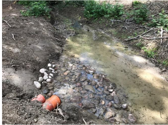
Bild 3 (vänster): Utloppsroren är lagda, del av bädden täckt med jord, slutförande av utloppet med stensättning framför utloppsroren pågår. Bild 4 (höger): Stensättningen framför utloppsroren. Det primära utloppsroret till vänster.
