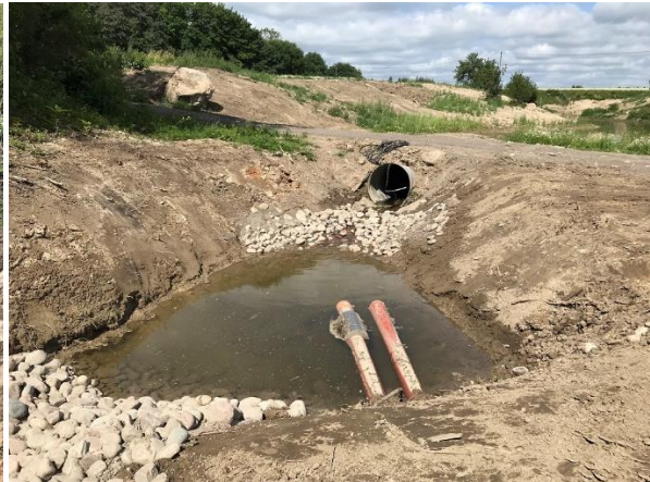
Bild 5 (vänster): Intagsrör lagda, intagshål uttaget och skyddande metallsil på det primära intagsroret installerad. Liten djuphåla för intagsroren utgrävd i diket. Bild 6 (höger): Stensättning lagd som erosionsskydd nedanför vägtrumman samt på den stabiliserande sektionen nedströms intaget. Vattennivån i djuphålan håller på att stiga. Fotot taget den 14 juli 2023.
