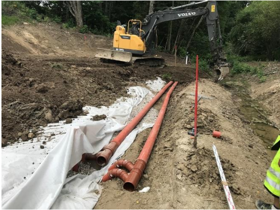
Bild 3 (vänster): Utloppsroren är lagda, del av bädden täckt med jord, slutförande av utloppet med stensättning framför utloppsroren pågår. Bild 4 (höger): Stensättningen framför utloppsroren. Det primära utloppsroret till vänster.
