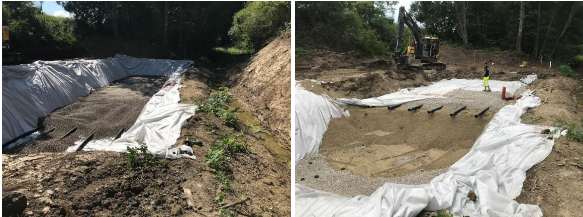
Bild 1 (vänster): Schakten av filtergropen är utförd. Bottenduk, bottenrör och bottenmakadam utlagda i större delen av filterbädden. Fotot taget den 11 juli 2023. Bild 2 (Höger): Kalkmaterial (hyttsand) utlagt i större delen av bädden. Makadam utlagt på topprören.
