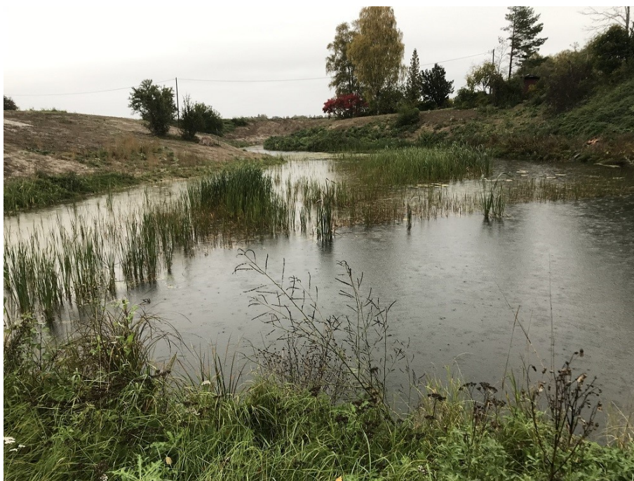
Dammens södra del den 6 oktober 2023. Foto från utloppet taget norrut.
