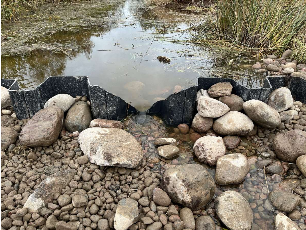
Bild 10. Ett motsvarande V-överfall som tidigare dämme har byggts.
