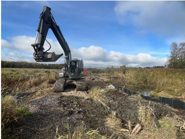
Bild 8-9. Sponten har tryckts ned med skopan till samma höjd som tidigare dämme. Gamla dämnet syns vid maskinens vänstra band.
