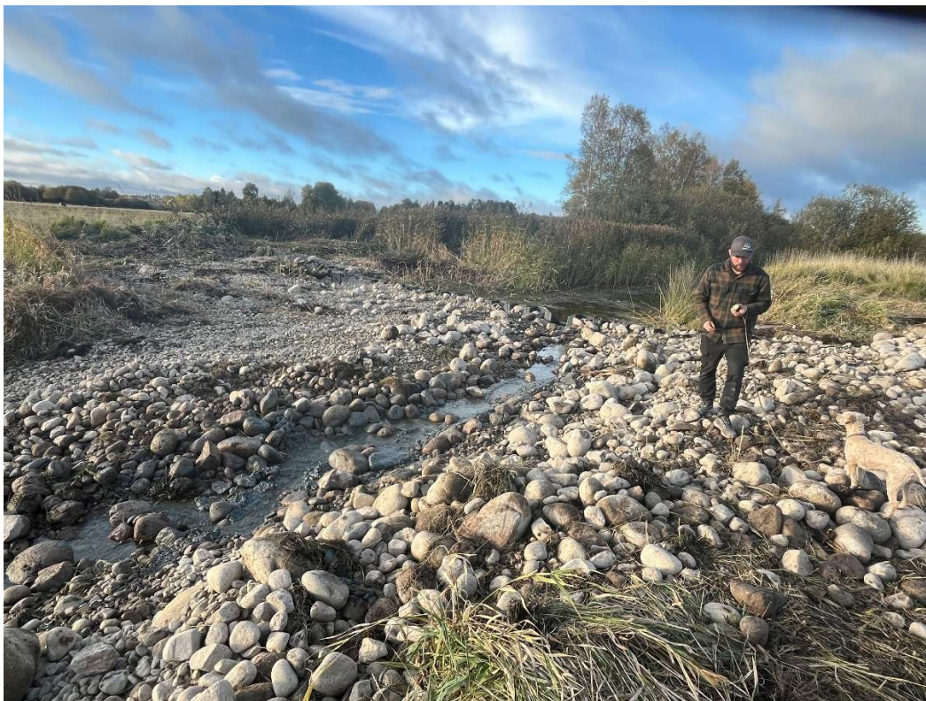
Bild 11. En central ränna har byggts, för att skapa en fiskväg vid lägre vattenflöden. Mer sten, i olika fraktioner, finns upplagd längs östra stranden om man behöver förstärka någon del framöver.
