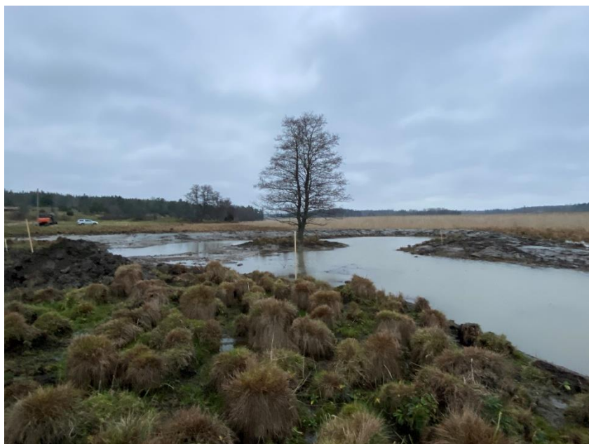
Bild 2: Vy över inloppsdel, där en djuphåla är grävd, så att vattnet går runt ön innan det rinner vidare genom våtmarken.
