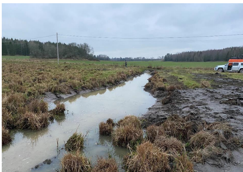
Bild 3: En extra fosforfälla gjordes i närliggande utfallsdike, men här kom stamledningen så lågt ut från åkern att ingen dämning har kunnat genomföras.
