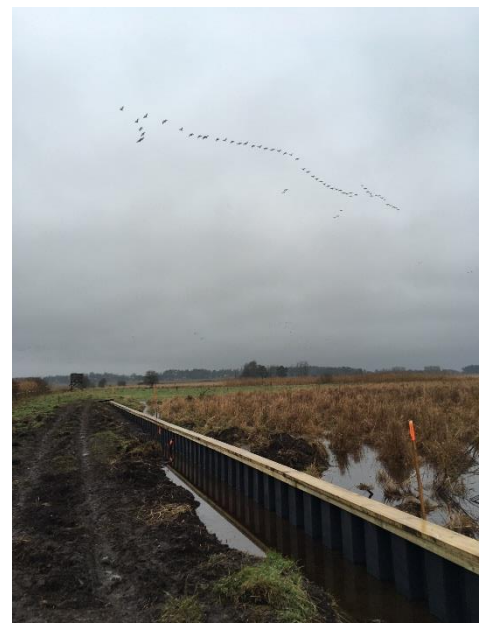
Förstärkning av vällen med plastspont. Foto: Ebba af Petersens
