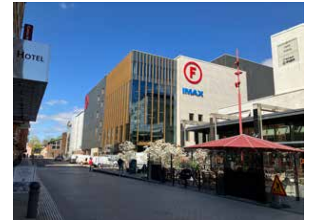
Ny bebyggelse i befintlig struktur längs Dragarbrunnsgatan.
