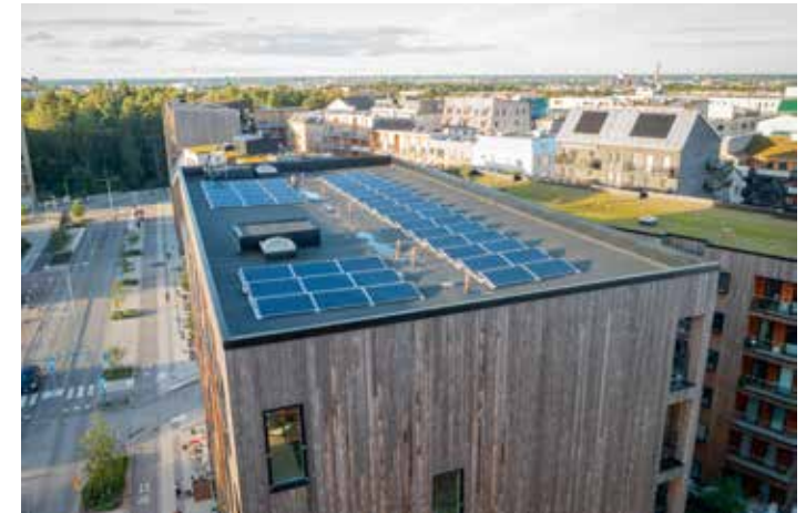
Exempel på solceller på taket.
