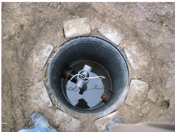
Dämningsbrunn av 600 mm vägtrummerör, sedd uppifrån. Foto: Bertil Aspernäs.
