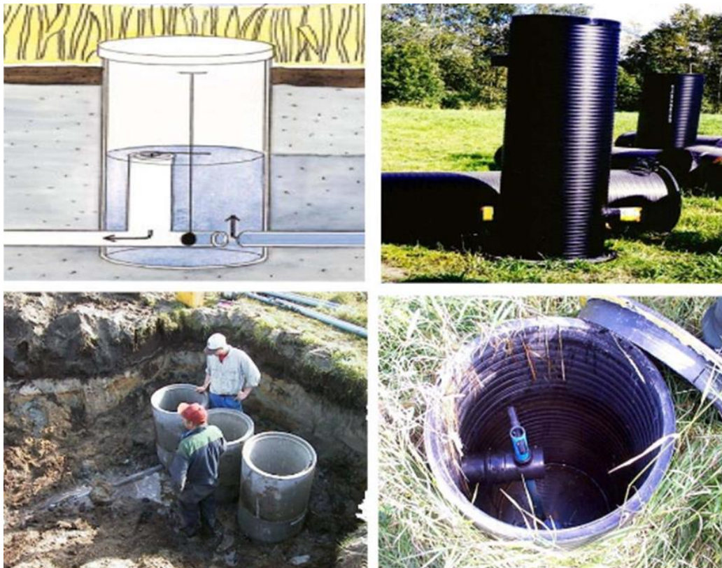
Principskiss på en dräneringsbrunn och utformning från verkligheten. Foto: Ingrid Wesström.
