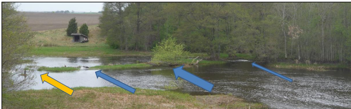
Figur 4b. Foto över dämnet vid Ensta. Pilarna markerar öppningarna som framgår av figur 4a.
