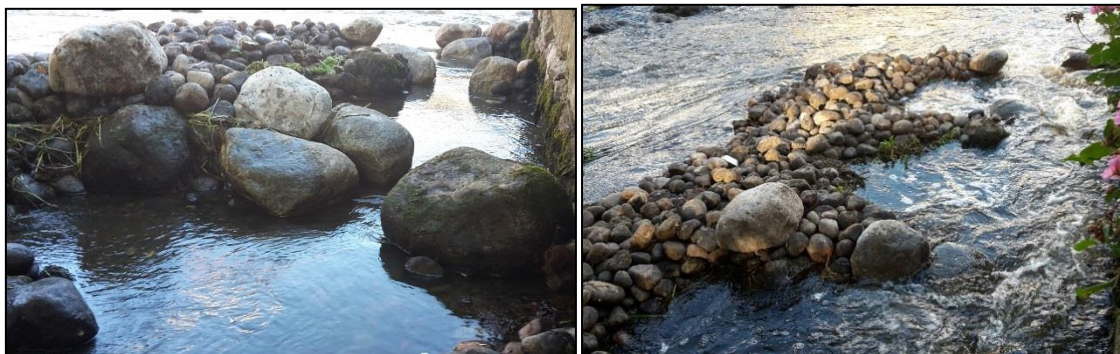
Figur 3. Exempel från på bassänger för att underlätta fiskvandring, till vänster med reducerat flöde och till höger med full vattenföring. Fotografierna är hämtade från omlöpet vid Kvarnfallet i Uppsala. Foto: Anders Larsson, Tyréns.
