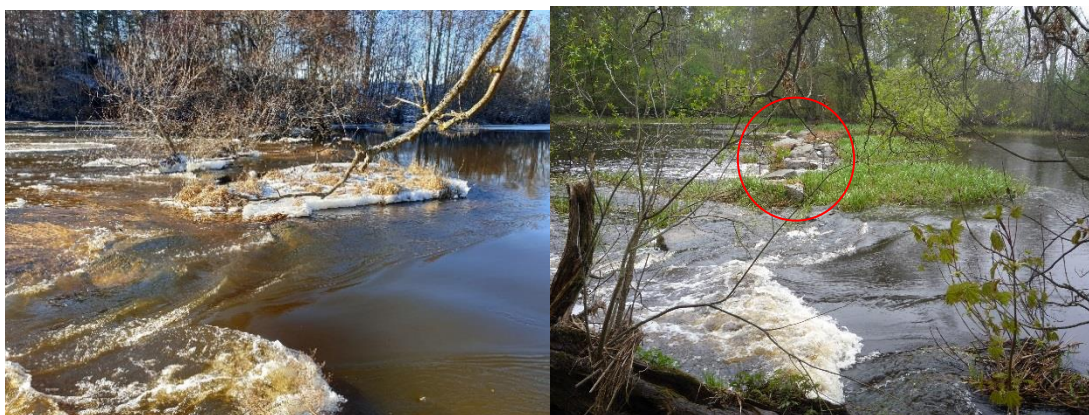
Figur 2. Ensta dammvall, vid hög (tv) respektive låg (th) vattenföring. Av det högra fotot framgår de förskjutna stenblock, markerade med röd ring, som kan komma att förskjutas i sidled. Foto: Anders Larsson, Tyréns
