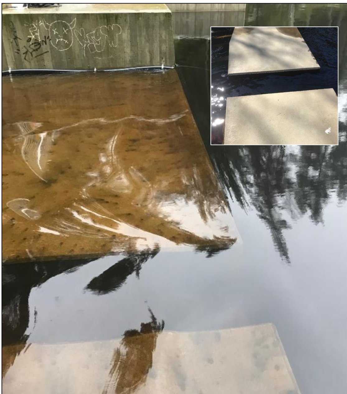
Figur 5. Fiskväg vid Lövsjön i Lerums kommun via genomföring i grunddamm. Infälld bild visar vid lågt flöde. Foton: Lars Pettersson, TerraLimno Gruppen AB.
