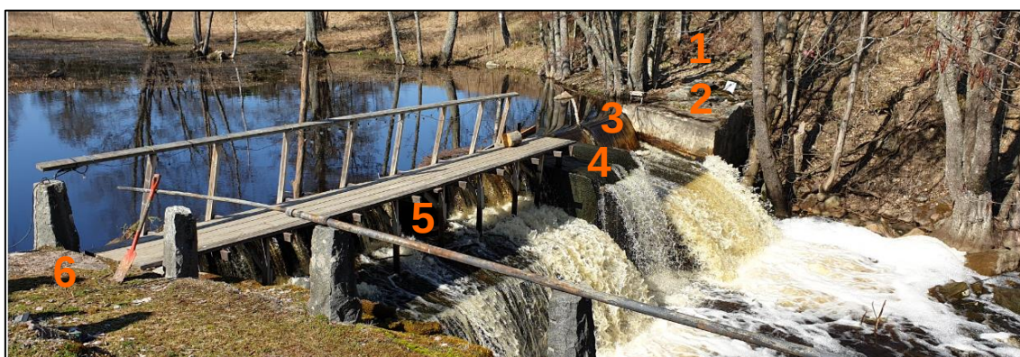
Figur 10. Fotografi som visar dämnet vid Rosta kvarn med nuvarande anläggningsdelar nr 1-6. Det igensatta utskovet, anläggningsdel nr 7, framgår av figur 26.
