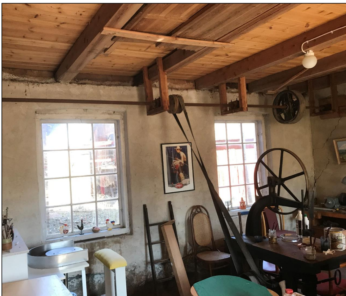
Figur 8. Exempel på bevarade anläggningsdelar i Rosta kvarn. Foto: Johanna Alton, Tyréns.
