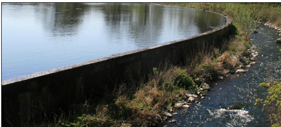
Figur 20. Fotografi som visar hur en damm kan avskiljas från ett inlöp med en betongmur. Foto: Silkeborg (Danmark). Lars Pettersson, TerraLimno Gruppen AB.
