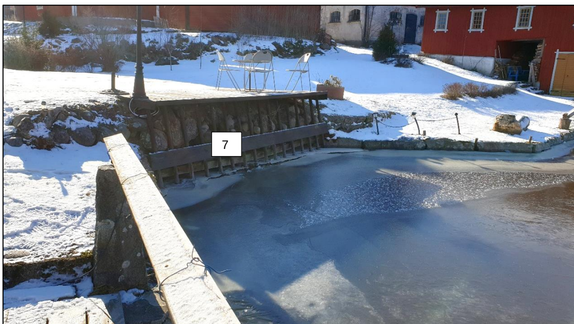
Figur 26. Igensatt intag till kvarnkanalen (anläggningsdel 7 i figur 9). Foto: Anders Larsson, Tyréns.
