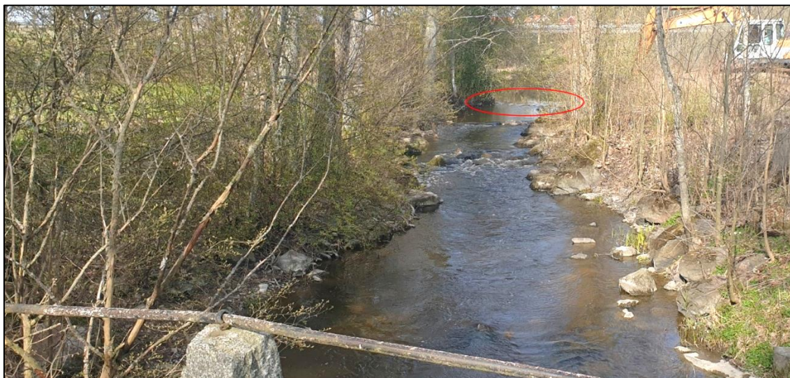
Figur 13. Grundtröskel vid inloppet till Norra kanalen markerad med röd ring. Foto: Anders Larsson, Tyréns.
