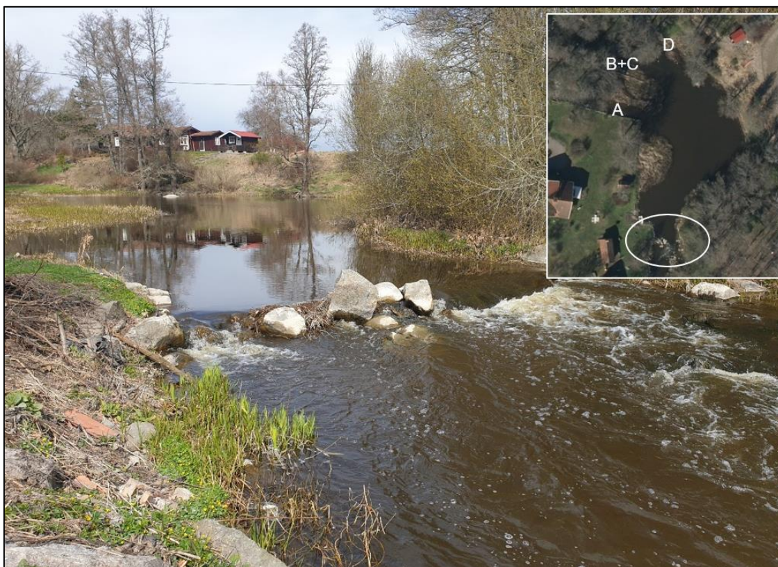
Figur 20. Grundtröskel nedströms sammanflödet (vit ring) med vattenvägarna A-D. Foto: Anders Larsson, Tyréns. Källa ortofoto: Uppsala kommun,
