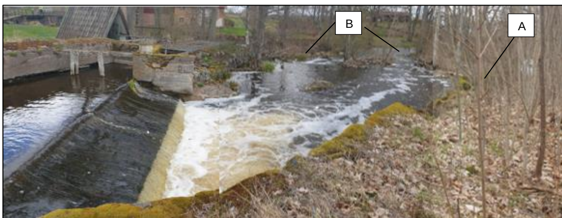
Figur 16. Skibord vid utloppet från Södra kanalen samt temporärt igensatt utskov till kanal förbi hus vid tidigare fiskodling. Vattenväg B och C markerade. Foto: Anders Larsson, Tyréns.
