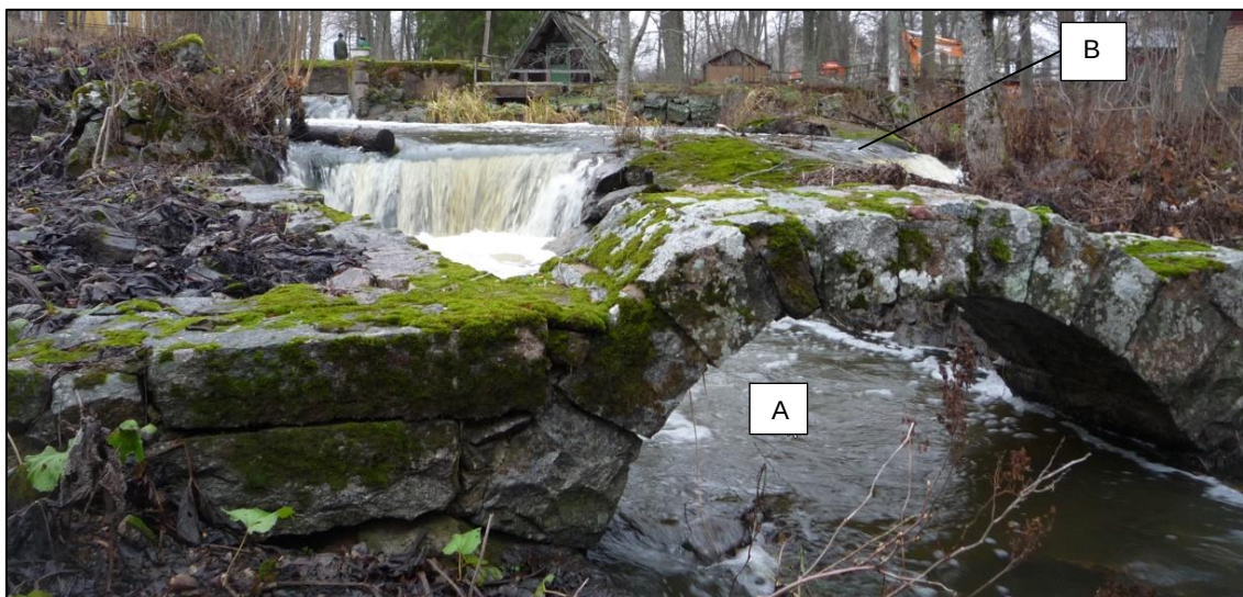
Figur 17. Strömfåra som rinner vidare mot ingång till vattenväg A. Foto: Anders Larsson, Tyréns.
