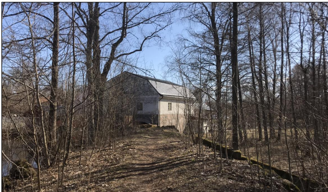
Figur 2. Kvarnbyggnaden med dammen till vänster. Vägen över Fyrisån ligger på en bank förstärkt med betong. Foto: Johanna Alton, Tyréns
