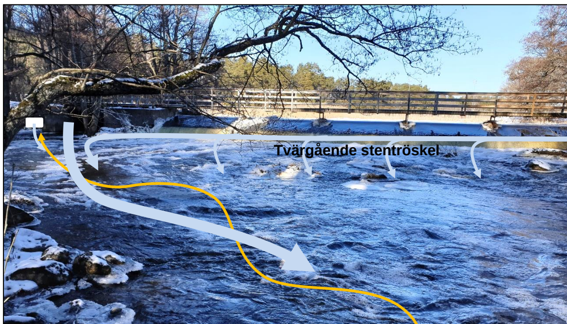
Figur 15. Vattnets flödesvägar och volymer illustrerade med olika tjocka pilar i ljusblå färg. Den tvärgående stentröskel som finns strax nedströms dämnet leder till att en betydande del av vattnet som faller över skibordet styrs mot västra utskovet. Genom att ansluta ett inlöp alternativt en slitsränna väster om dammluckorna (vit rektangel) förenklar det för fisk att orientera ingången till fiskvägen (illustrerad med gul linje) både vid stängda och öppna luckor i västra utskovet.
