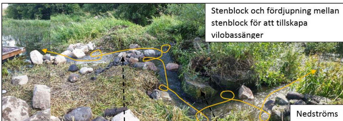
Figur 5. Fotot visar öppning 3 i Ensta dämme efter åtgärd och med en pil som visar strömsträckor och respektive viloplatser för fisk. Foto: Anders Larsson, Tyréns.
