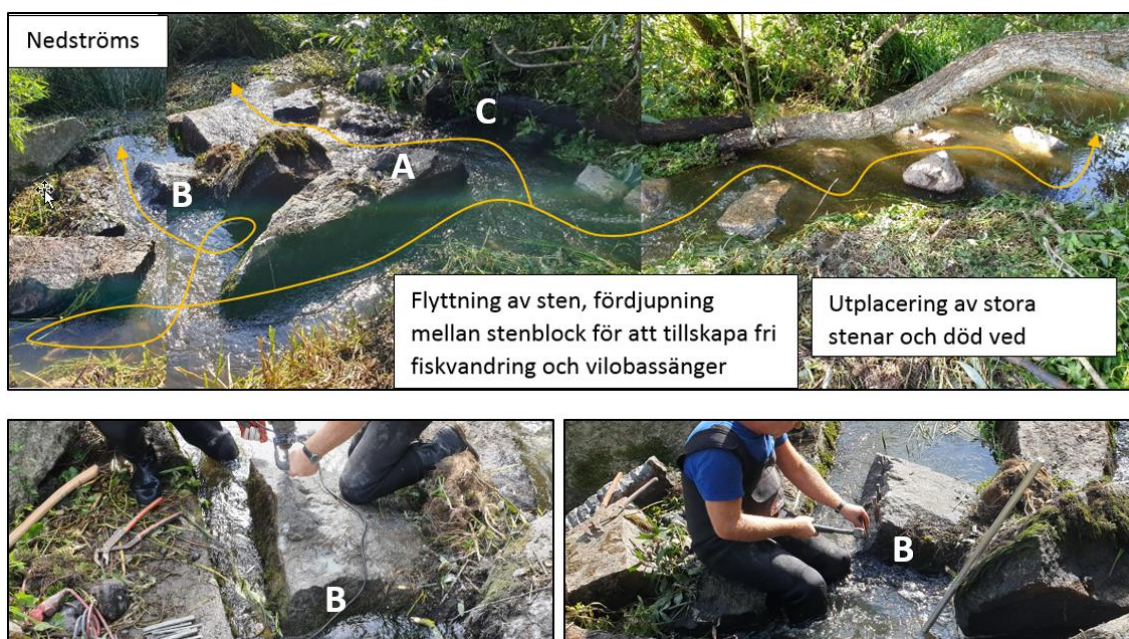
Figur 4. Bilderna markerar fiskpassager och åtgärder vidtagna vid Ensta dämme i öppning 2. Foto: Anders Larsson, Tyréns.
