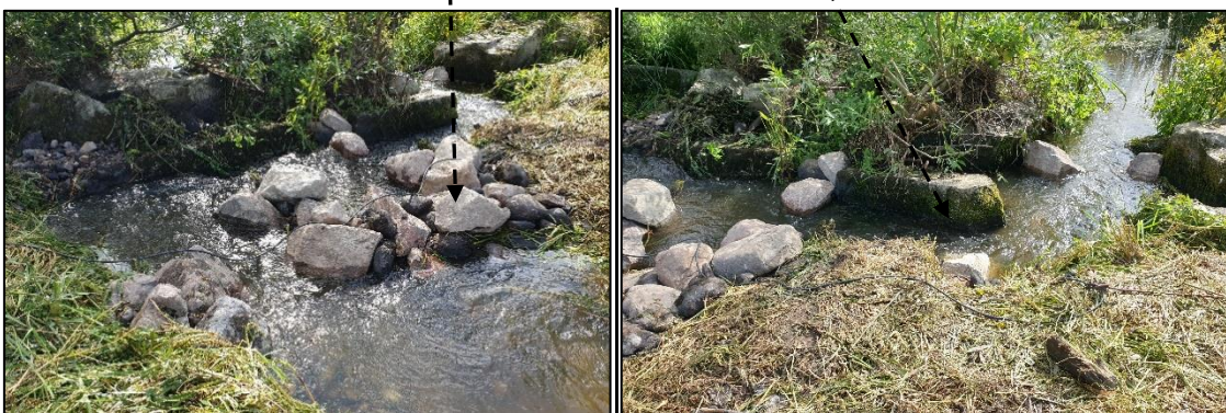
Figur 6. Närbilder på vidtagna åtgärder i öppning 3 vid Ensta dämme. Foto: Anders Larsson, Tyréns.
