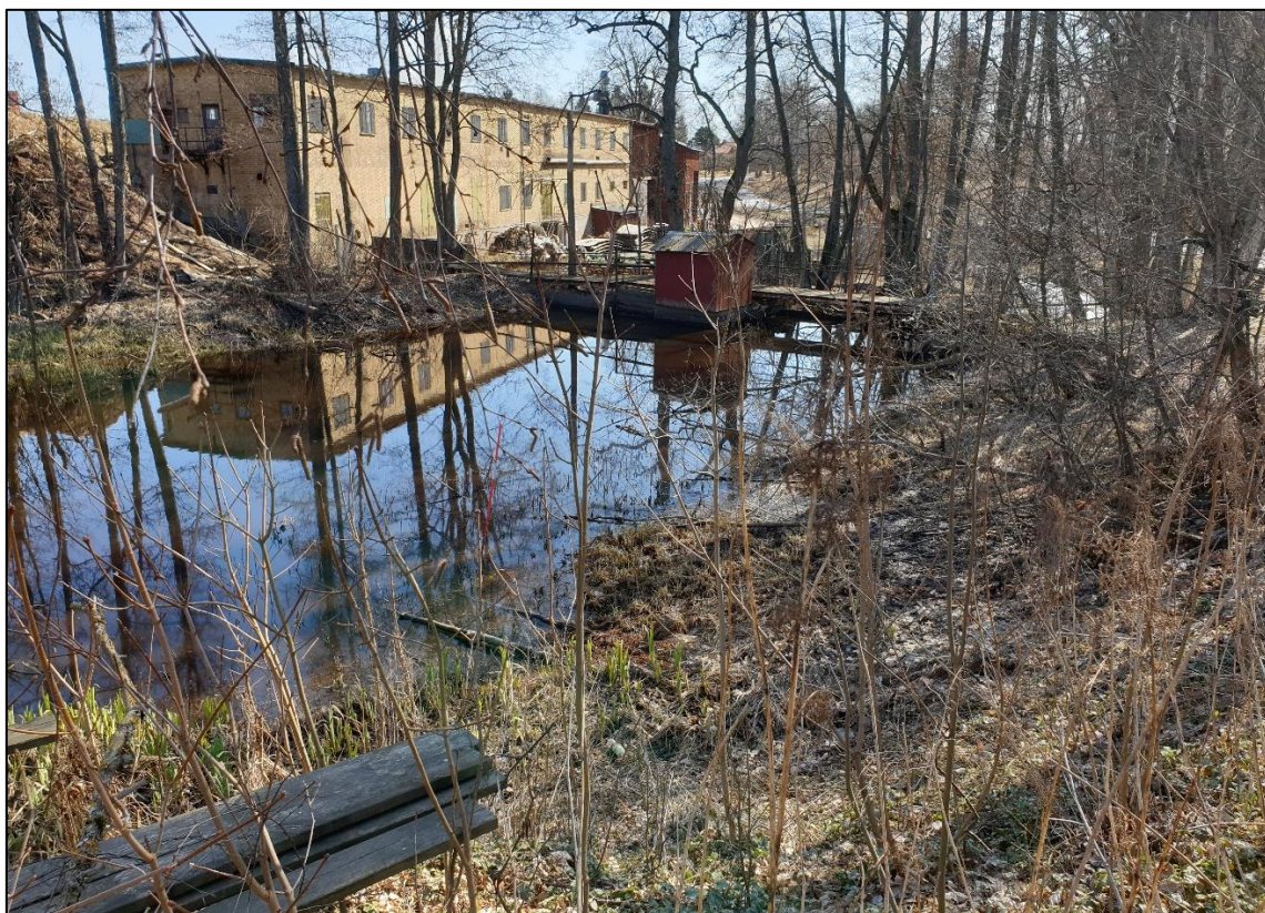
Figur 3. Nyby sågdamms vy från uppströms sida. Foto: Anders Larsson, Tyréns
