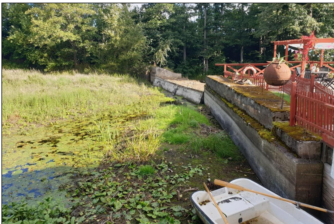
Figur 13. Dragby kvarn 201015 då flödet var lågt och allt vatten passerade via dammkroppen. Foto: Anders Larsson, Tyréns
