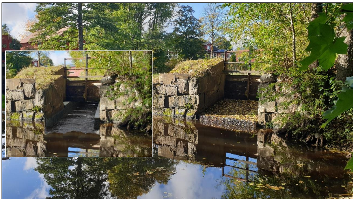
Figur 22. Befintligt sättutskov och infälld illustration med ingången till en slitsränna som ersätter nuvarande utskov. Foto: Anders Larsson, Tyréns.
