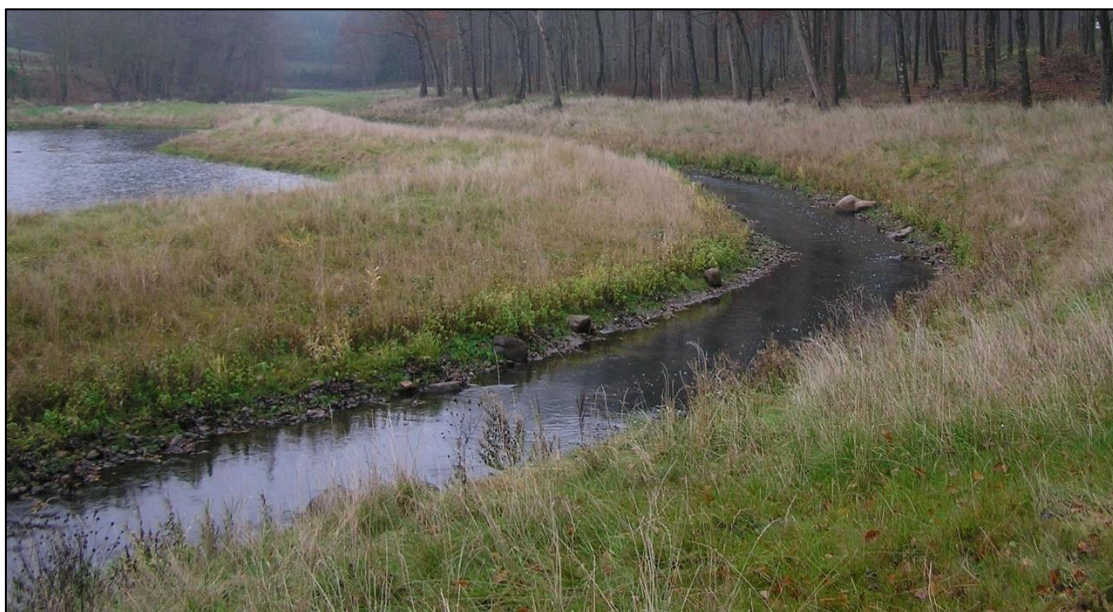
Figur 19. Fotografi som visar hur en damm kan avskiljas från ett inlöp med en betongmur (övre bild) respektive en jordvall (nedre bild). Foton: Silkeborg (Danmark). Lars Pettersson, TerraLimno Gruppen AB.
