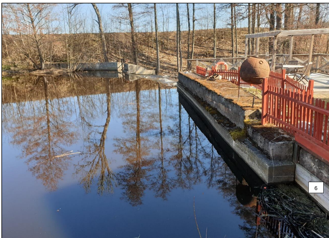
Figur 12. Dragby kvarn 190416 då flödet var så pass högt att vatten avbördades både igenom dammkroppen och via skibordet. Foto: Anders Larsson, Tyréns
