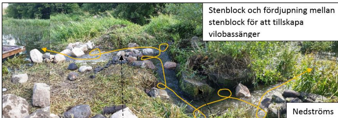
Figur 6. Fotot visar öppning 3 i Ensta dämme efter åtgärd och med en pil som visar strömsträckor och respektive viloplatser för fisk. Foto: Anders Larsson, Tyréns
