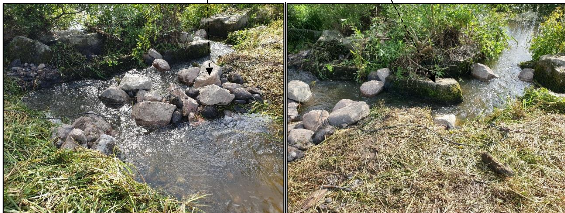
Figur 7. Närbilder på vidtagna åtgärder i öppning 3 vid Ensta dämme. Foto: Anders Larsson, Tyréns
