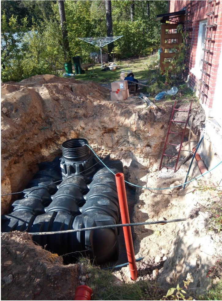
Figur 13. Nergrävning av 5 m 3 regnvattentank (Foto: privat).
